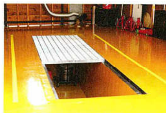
上 / どうしてもガレージに欲しかったのがピット。クルマのサイズから幅1000mmを割出し、深さは作業しやすいように1000mmとした。
